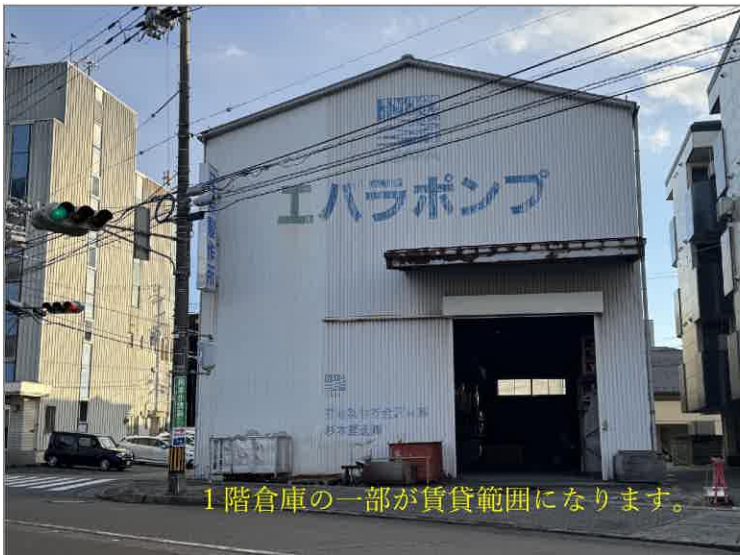
倉庫北側から撮影
